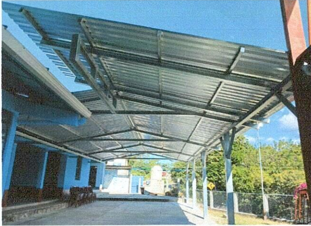
Foto 1: Instalación de estructura de techo tipo portico y cubierta de lamina calibre 26
